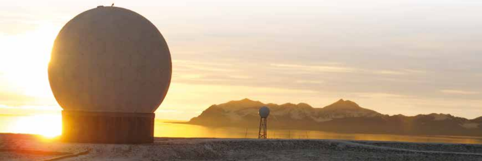
Station sol d'EUMETSAT à Svalbard
